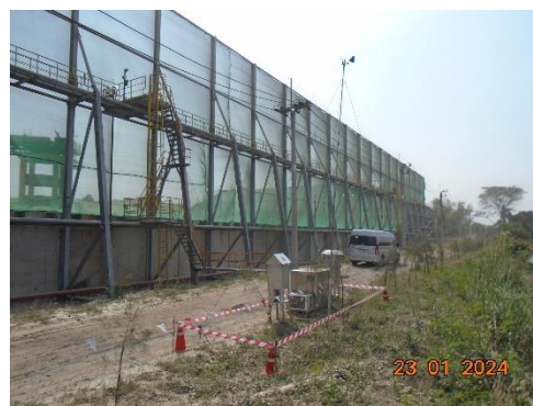
ภาพที่ 2-8 แนวตาข่ายรอบลานกองกากอ้อย กองขี้เถ้า และกากตะกอนหม้อกรอง
