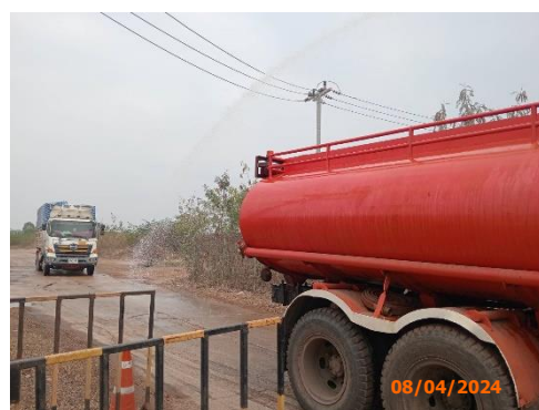
ภาพที่ 2-64 การล้างล้อรถบรรทุกและการทำความสะอาดผิวจราจร บริเวณทางเข้า-ออกโครงการ
