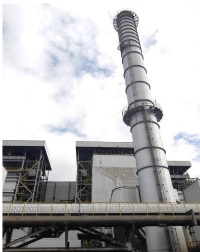
หม้อไอน้ำ ขนาด 160 ตัน/ชั่วโมง (No.3)
