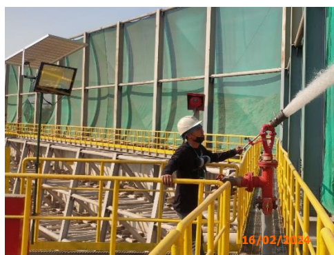
ภาพที่ 2-13 ระบบดับเพลิงโดยรอบลานกองกากอ้อย
