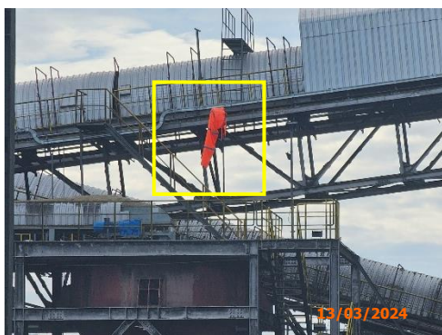
ภาพที่ 2-15 ถังลมที่ลานกองเก็บเถ้าและกากตะกอนหม้อไอน้ำ และพื้นที่ผลิตปุ๋ยหมัก
