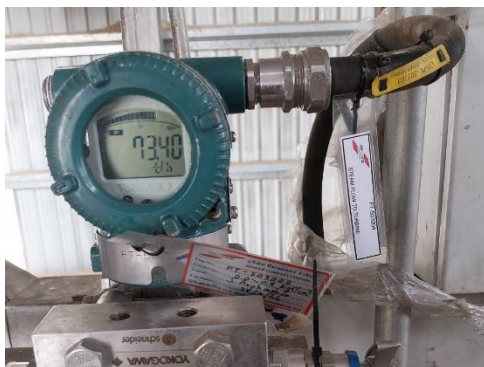
ภาพที่ 2-5 ติดตั้งอุปกรณ์สำหรับตรวจวัดปริมาณไอน้ำที่หม้อไอน้ำ
