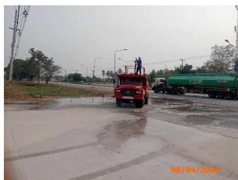
ภาพที่ 2-63 การล้างล้อรถบรรทุกและการทำความสะอาดผิวจราจร บริเวณทางเข้า-ออกโครงการ
