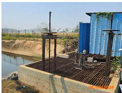
ภาพที่ 2-55 ถังตรวจสอบสภาพน้ำ
