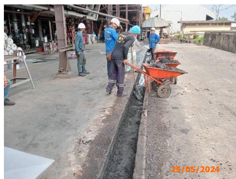
ภาพที่ 2-12 การขุดลอก-ทำความสะอาดรางระบายน้ำ
