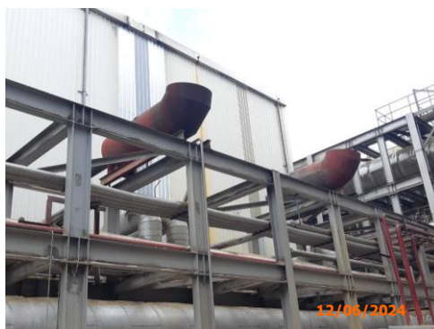
ภาพที่ 2-38 ติดตั้งวัสดุปิดครอบแหล่งกำเนิดเสียงดัง
