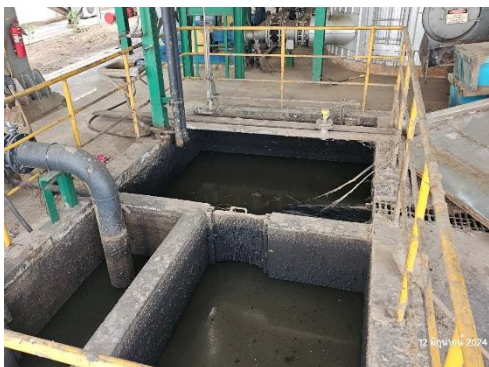
ภาพที่ 2-27 บ่อดักน้ำมัน (Oil Separator)
