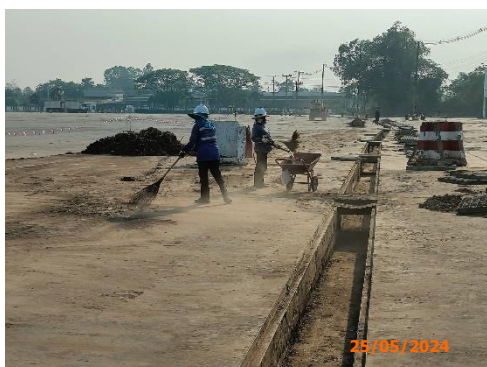
ภาพที่ 2-12 การขุดลอก-ทำความสะอาดรางระบายน้ำ
