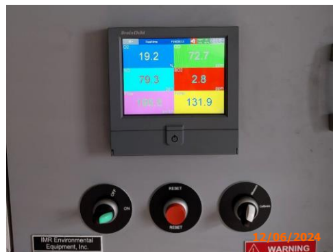
ภาพที่ 2-6 ระบบตรวจวัดคุณภาพอากาศแบบต่อเนื่อง (CEMS)
