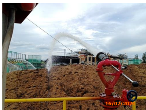
ภาพที่ 2-13 ระบบดับเพลิงโดยรอบลานกองกากอ้อย
